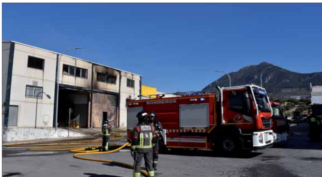
El fuego afectó a la nave de almacén de Aldecort y llenó de humo otra aldaña/FP
