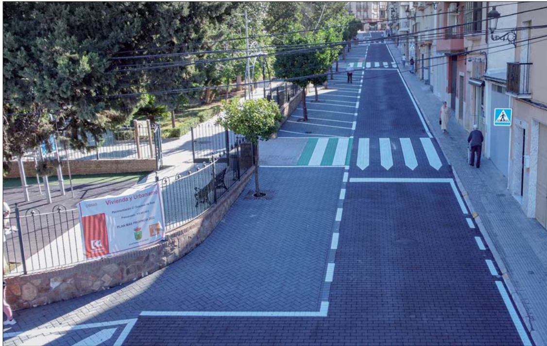
Aspecto de la calle Duquesa tras su remodelación y antes de su reapertura/EC
