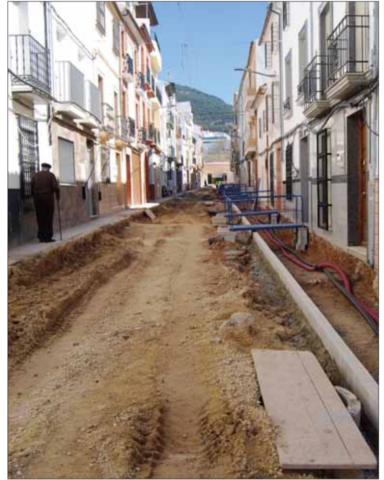
En la calle Canalejas se está actuando sobre el pavimento y acerado/MM
