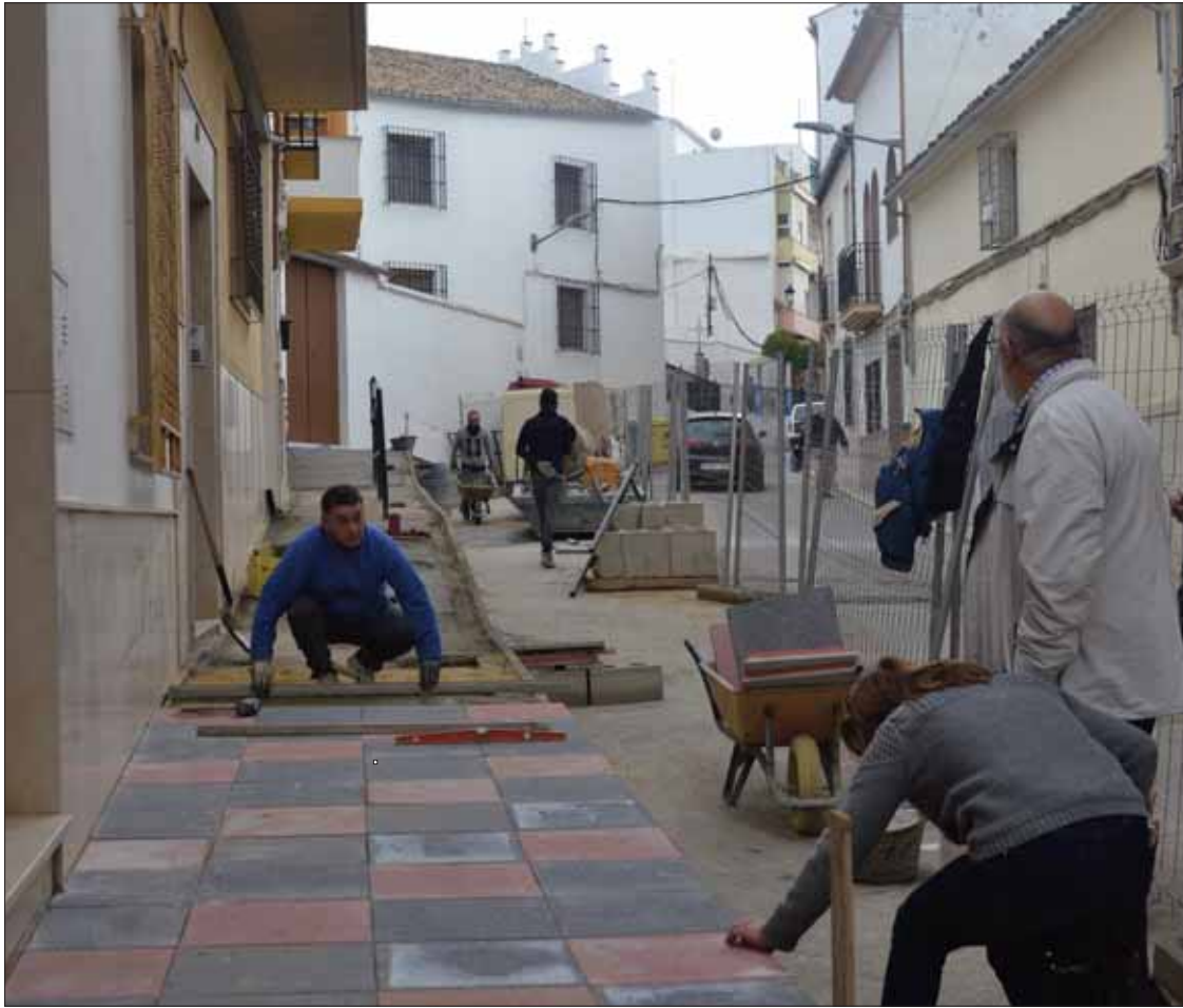
En la calle Lucena se está ampliando la peana para mejorar su accesibilidad/MM
