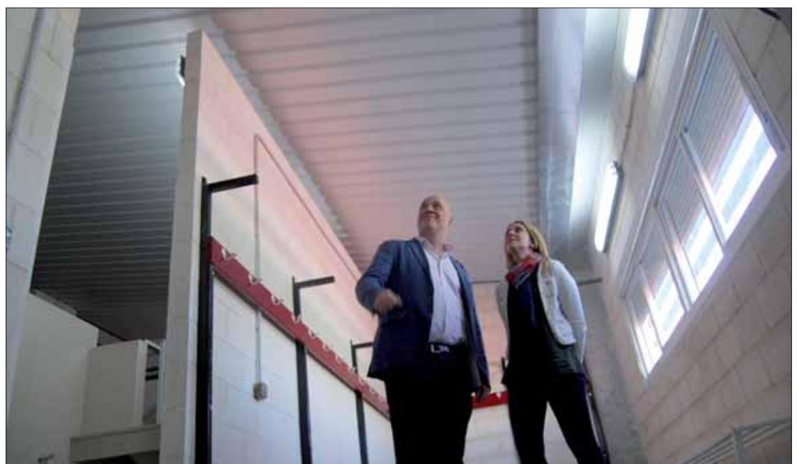
El alcalde y la concejala de Deportes supervisan el falso techo que se ha colocado bajo la tribuna/FP
