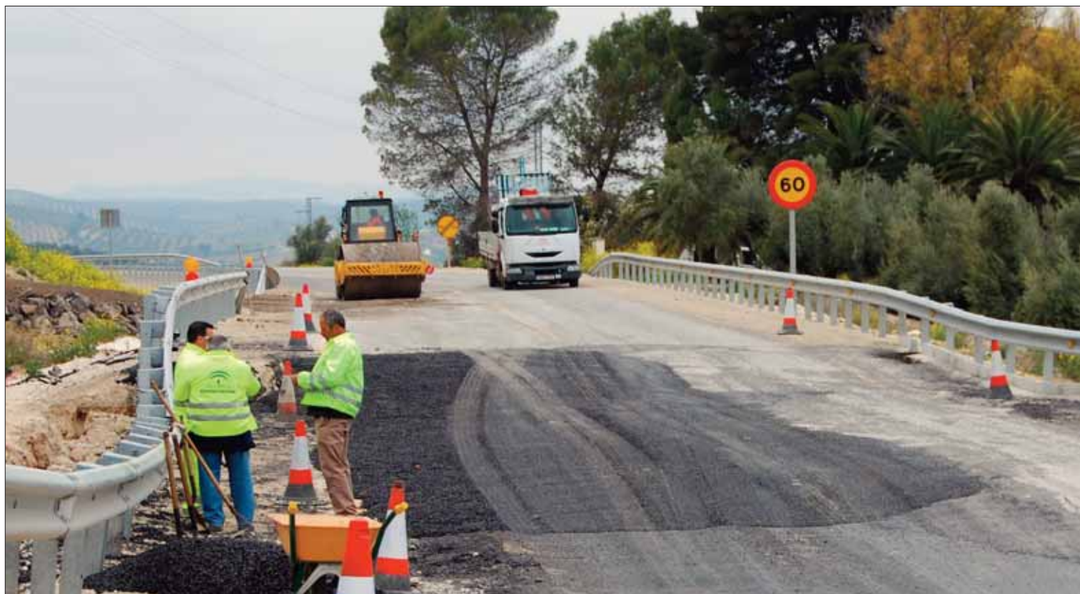
Las obras de la carretera se interrumpieron en el año 2008/Archivo
