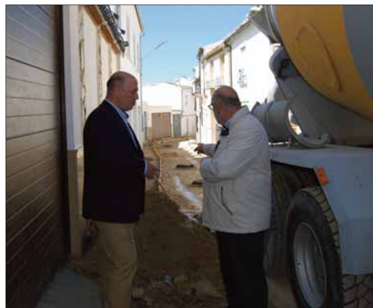
Antonio Ruiz y Manuel Muñoz visitan las obras de la calle Alta/MM
