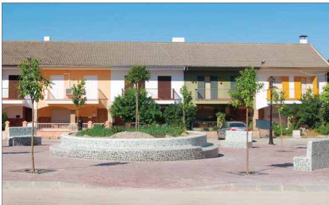
Se ha apostado por el embellecimiento y mejora de la plaza del la barriada de Los Manzanos/MM
