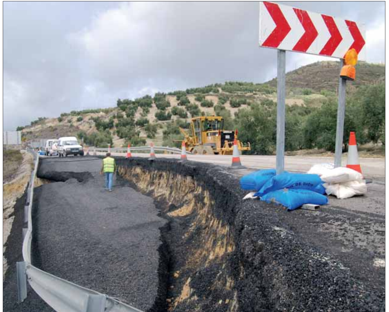
Los operarios continúan organizando el tráfico y trabajando en el carril inhabilitado/FP
