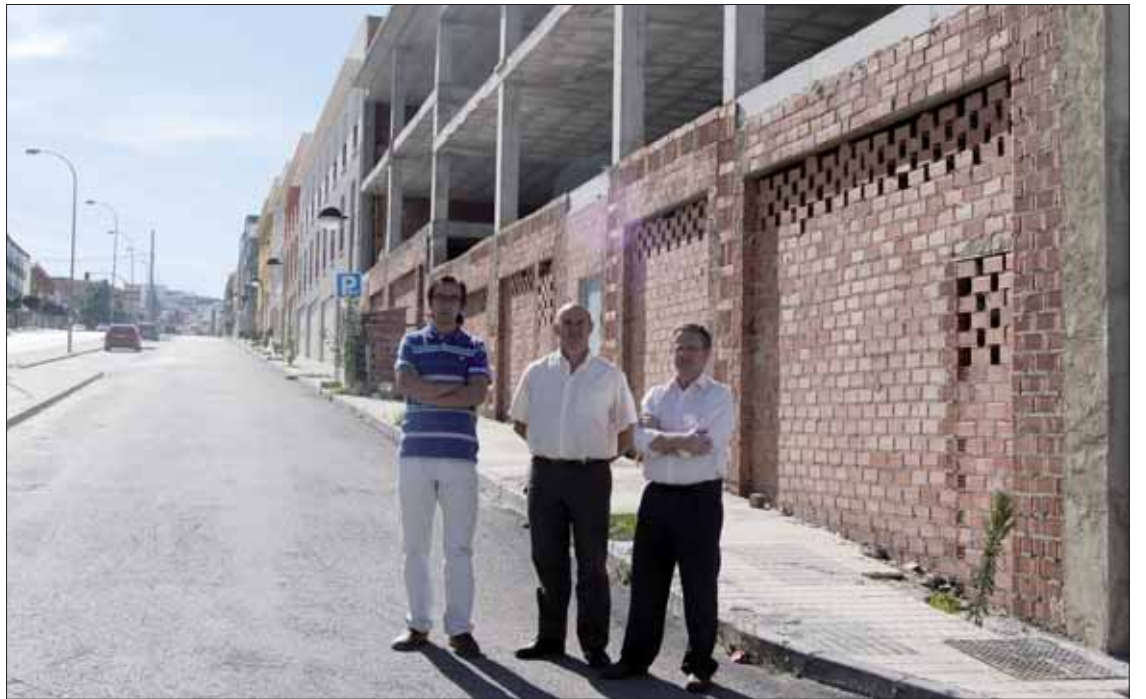
El gerente de Anzur 06, el alcalde y el técnico municipal junto al edificio de VPO/MM
